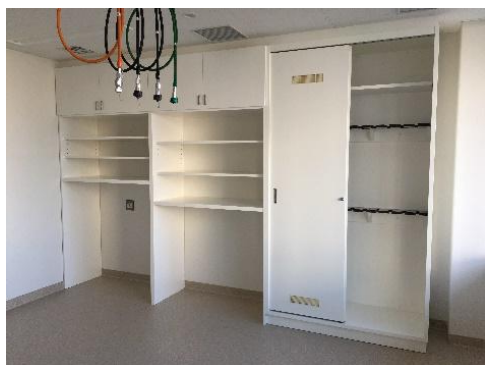
◇内視鏡保管庫 カート等がそのまま収める ことが出来る蹴込み式収納
