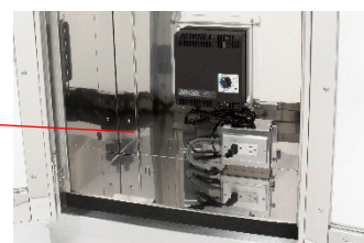
■ 除湿機収納部内部 （パンチングカバー外したところ）
